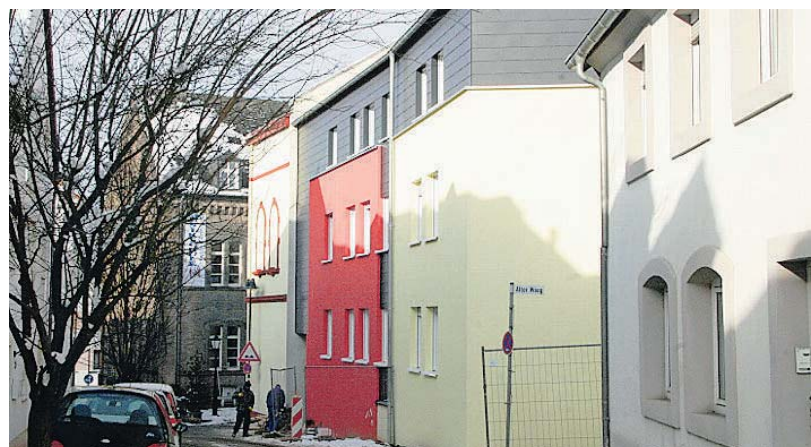
Noch wird in der Hospitalstraße fleißig gewerkelt. Mitte Februar sind die Senioren-Wohngemeinschaften bezugsfertig. Foto: gog
