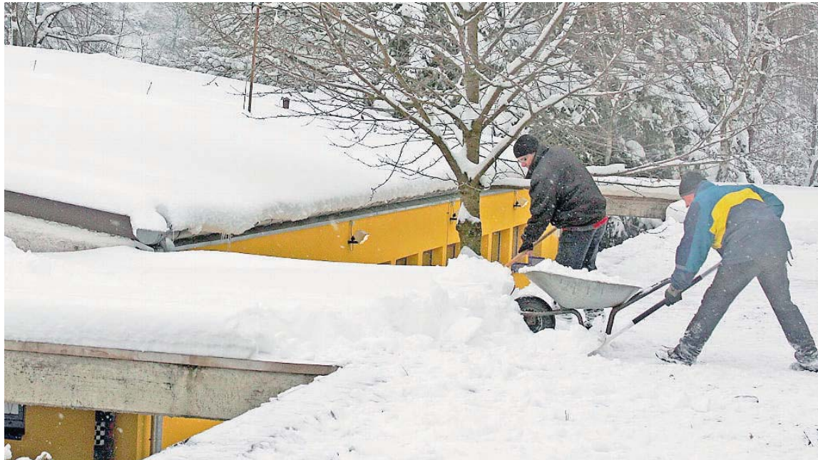
Schneeräumarbeiten gestern auf dem Dach der Annenschule in Furschweiler.
