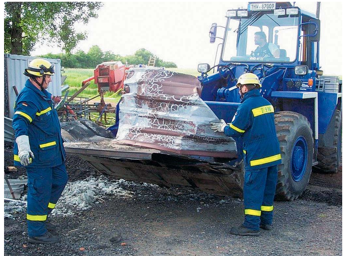
Einsatz der Fachgruppe Räumen auf dem Römerhof in Alsweiler.
