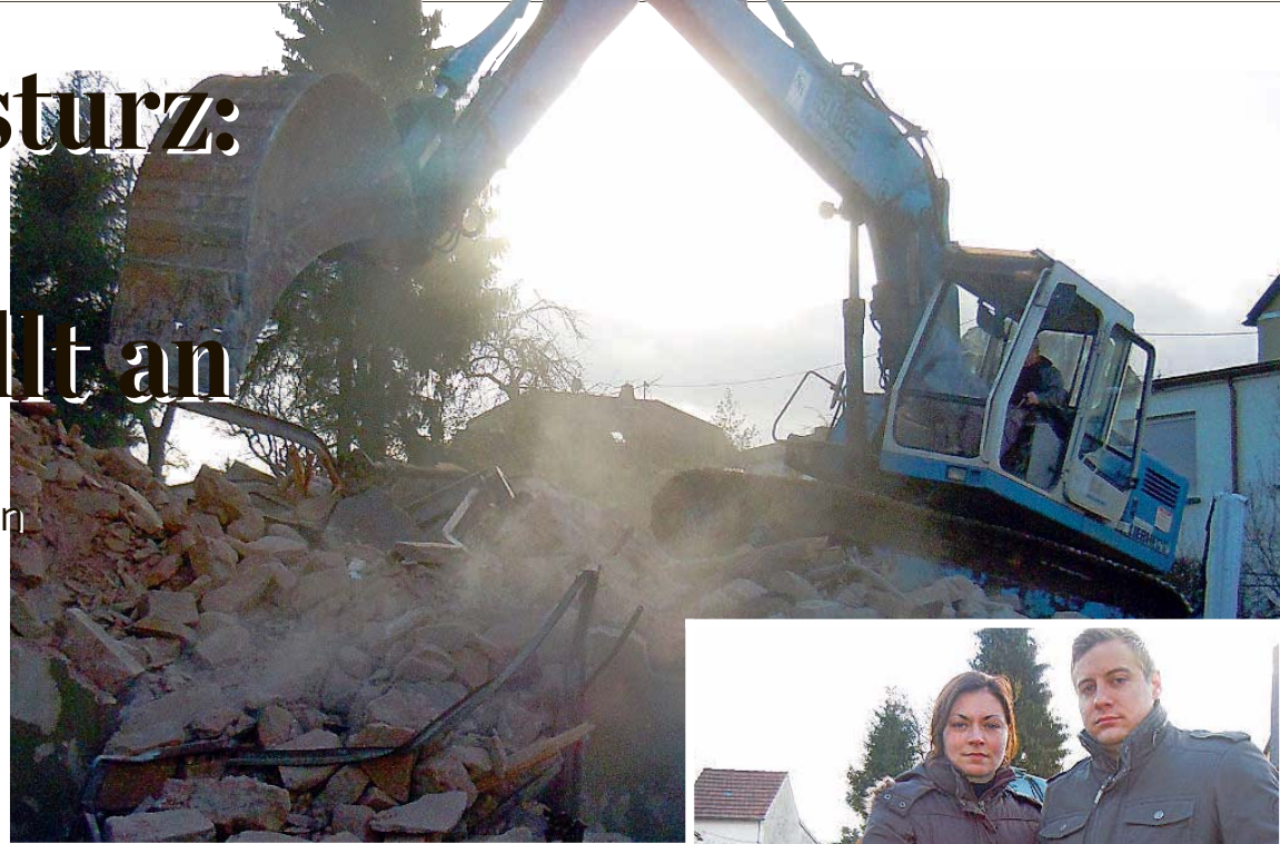
Ein Bagger aus Marpingen reißt am Freitagmittag die verbliebenen Trümmer des Hauses in Winterbach ein. FOTOS: HGN (2)/KRANSERVICE RECH (3)
