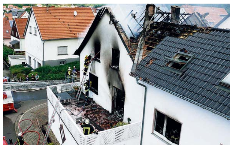
Auch mit der Drehleiter rückten die Feuerwehrleute den Flammen von Außen zu Leibe (oben). Das Dach von einem Teil des Gebäudekomplexes ist komplett ausgebrannt (unten). FOTOS: FEUERWEHR
