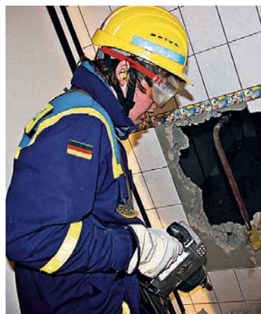
Moritz Schmitt beim Mauerdurchbruch.
