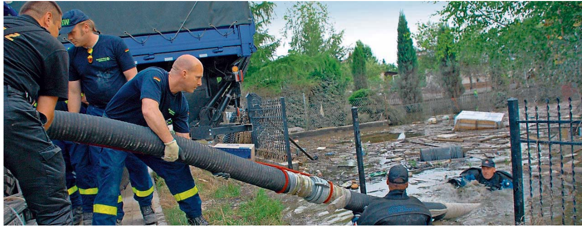
Die Fachgruppe Wasserschaden/Pumpen sind spezialisiert auf Hochwasser und Starkregen.
