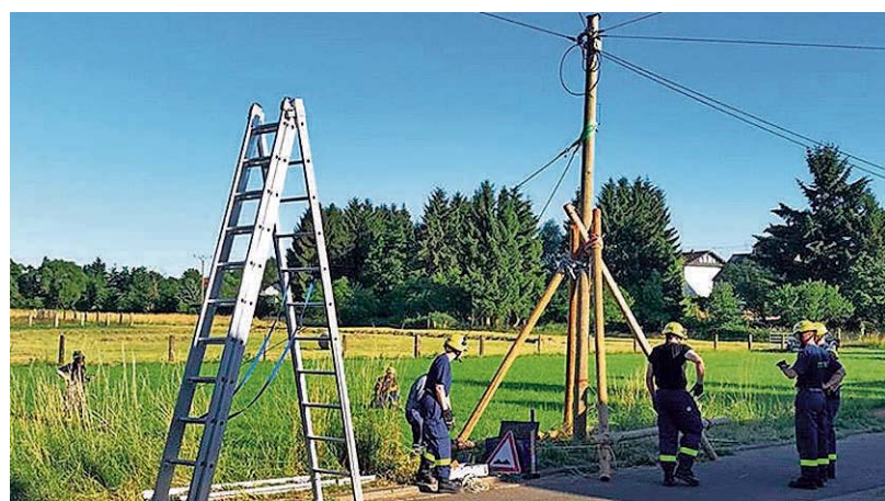
THWler richten Telefonmast wieder auf. FOTO: THW/CHRISTIAN DHUM
