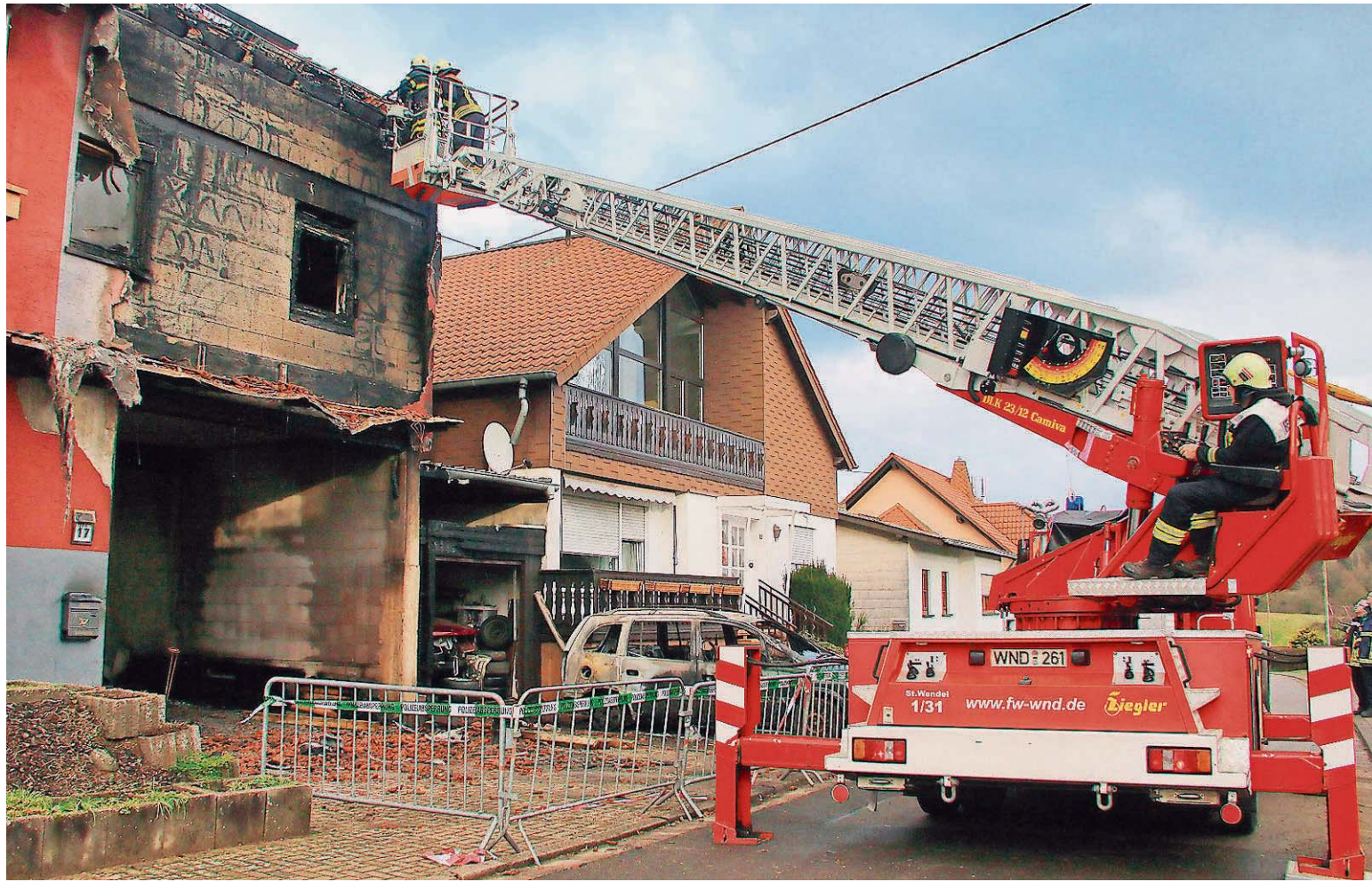
Am Tag nach dem Brand: Noch immer muss sich die Feuerwehr um das teils zerstörte Haus in Winterbach kümmern. FOTOS: B&amp;K
