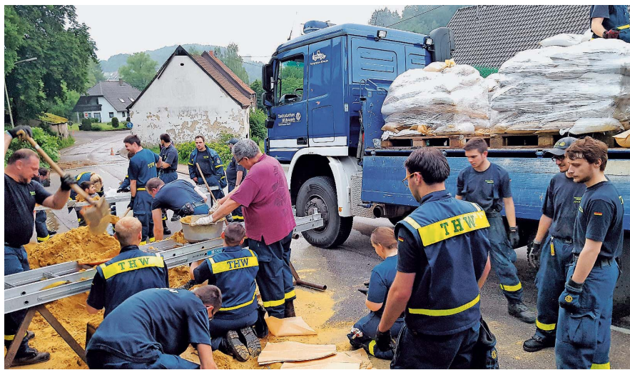
Auf Hochdruck: THWler füllen Sandsäcke in Berschweiler gegen die Flut. FOTO: MARKUS TRÖSTER
