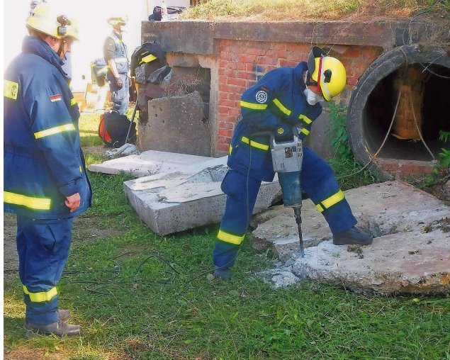
THW-Grundausbildung: Prüfer Martin Klees (links) beobachtet wie THW-Helferin Manuela Schweickhardt mit dem Bohr- und Aufbrechhammer umgeht. FOTO: FABER
